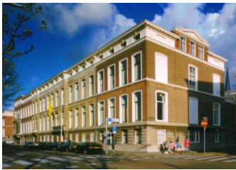
Renovatie en nieuwbouw NOVIB Den Haag
